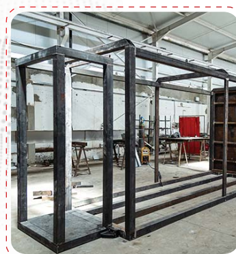
Assemblage des détails des structures en acier en détaillant les dessins
